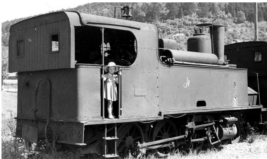
FIGURE 10.4 – Locomotive 130T Corpet-Louvet n°4 garée froide à Besançon-Rivotte en 1950. On peut remarquer l'abri en bois de fabrication locale pour protéger le mécanicien et le chauffeur des intempéries (collection Lornet).
