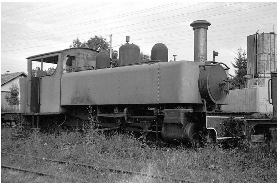
FIGURE 11.1 – Locomotive Baldwin des C.F.D. abandonnée en gare d'Andelot, probablement peu de temps avant son enlèvement, en 1948. On peut remarquer l'allongement des caisses à eau réalisé dans les ateliers du réseau (cliché P. Laurent †).
