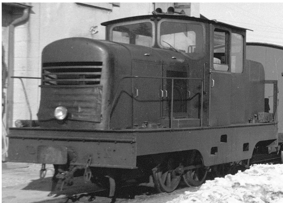
FIGURE 16.3 – Locotracteur n°103 vu au cours de l’hiver 1952–1953 à Levier. Une bâche a été apposée sur le bas de la calandre avant, afin de protéger les organes des projections de glace et de neige (cliché C. Lornet).
